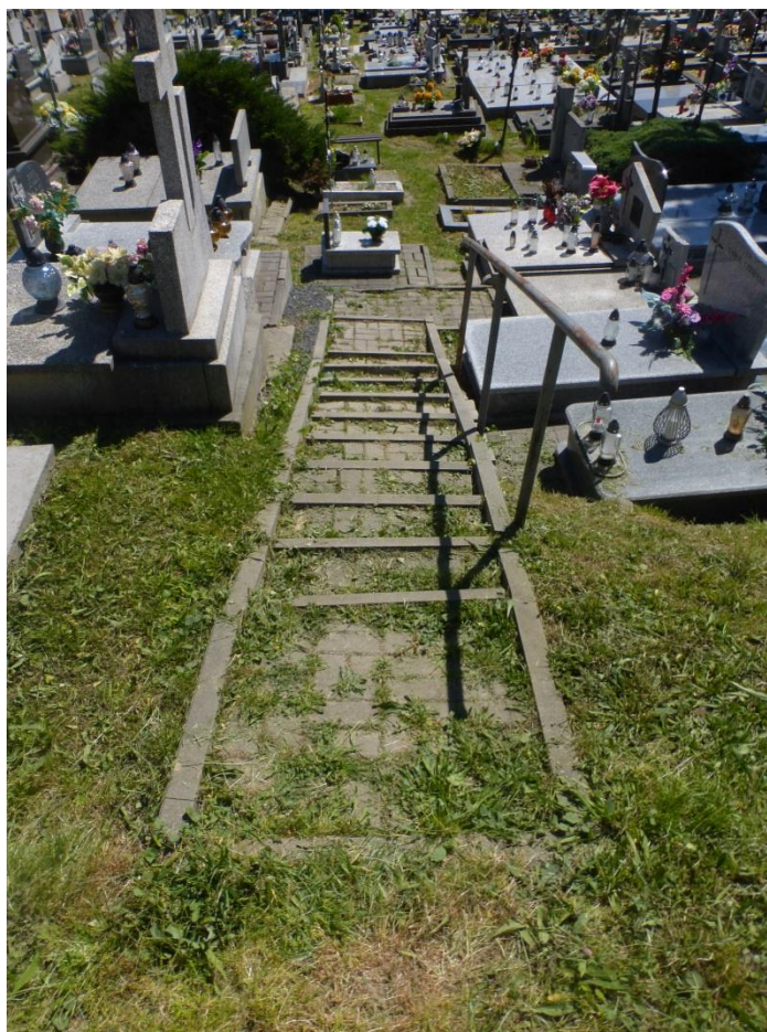
WIDOK NA CIĄG SCHODÓW
